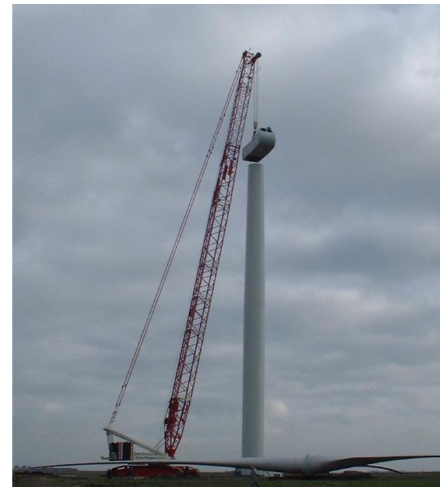
Montage de la nacelle
