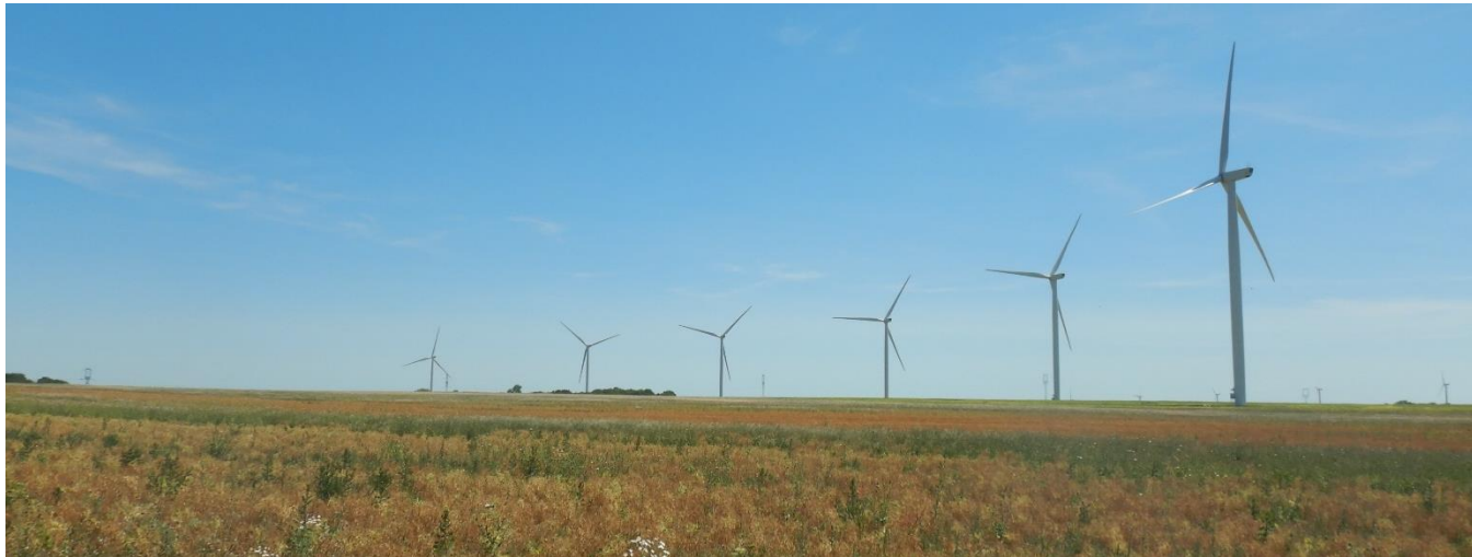
Photo 11 : éoliennes du parc de REUILLY et DIOU Énergies au nord de la zone du projet
