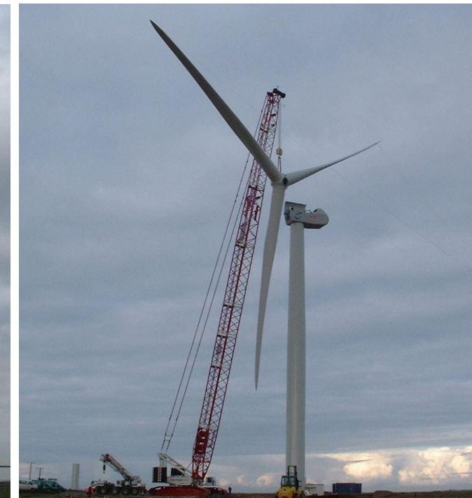
Montage du rotor
