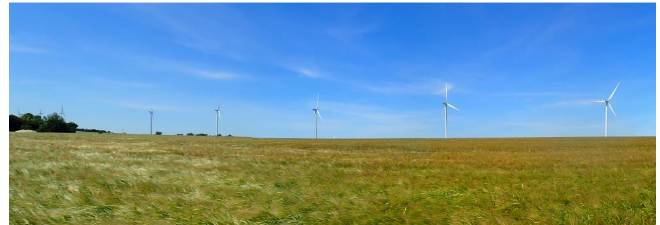
Photo 12 : parc éolien d'Aubigeon
