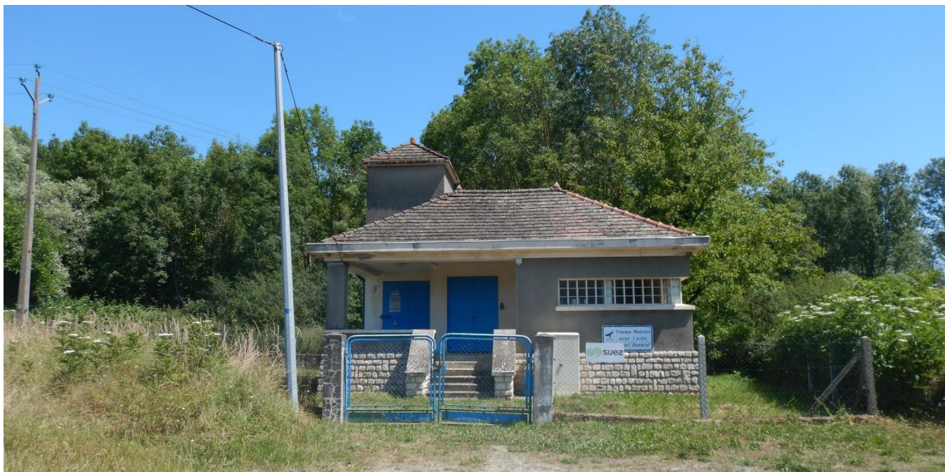
Photo 5 : bâtiment d'exploitation du captage d'eau potable de Diou
